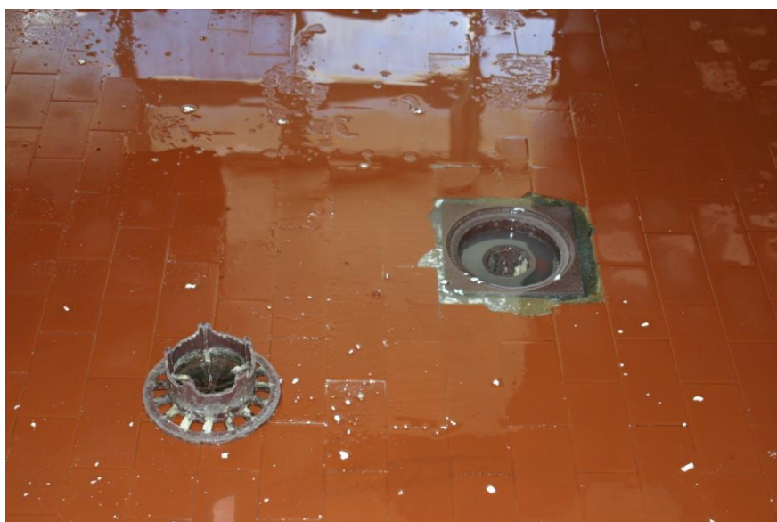
Figura 6: Particolare della pavimentazione e di un pozzetto di scarico reflui
