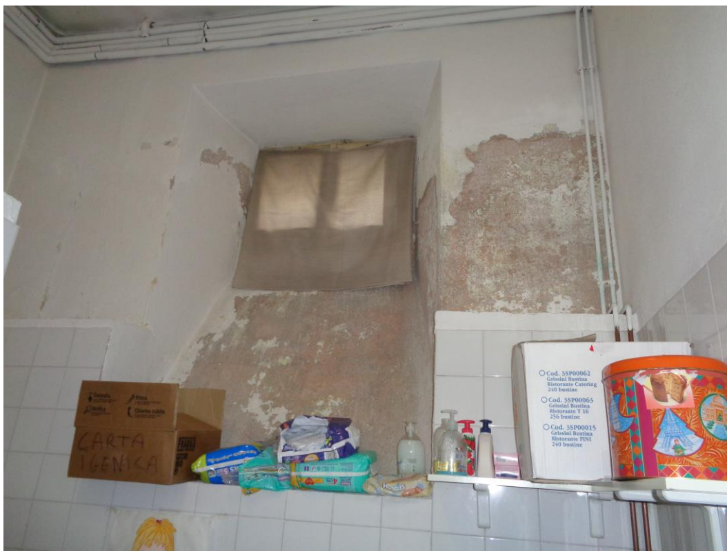
Vista dei locali interni destinati a scuola dell'infanzia, con evidenza della parete ammalorata
