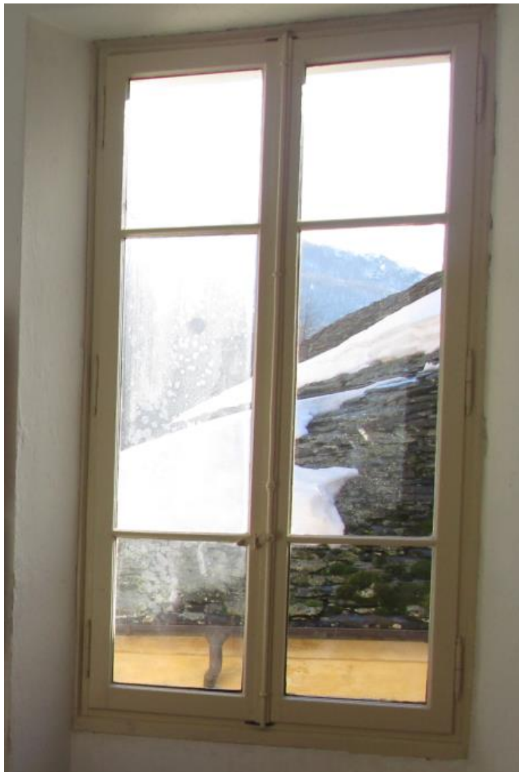
Vista serramenti esistenti da restaurare con l'inserimento di vetrocamera antisfondamento destinati alla scuola
