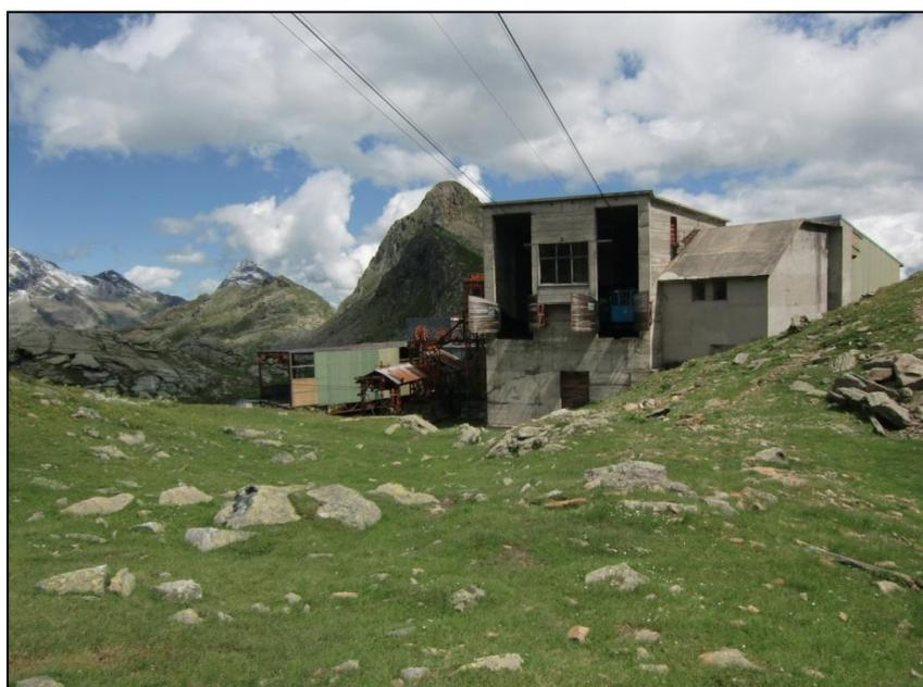
*Figura 2/2 Stazione di valle - Vista da monte, lato nord, Punta Indren. Sul fronte le aperture della zona di imbarco – sbarco. Sulla sinistra la teleferica di prevista demolizione*
