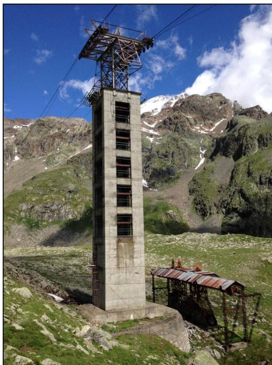
Figura 2/4: Sostegno n. 2 Vista frontale, da valle – Le parti di prevista demolizione sono costituite dalle strutture funiviarie di sommità e dalla teleferica di servizio, alla base.
